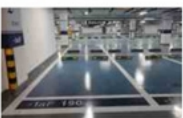
地下车库墙面
