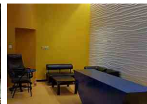
店面内墙翻新
