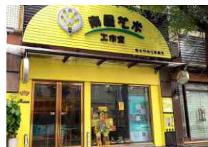
店铺门头外墙翻新
