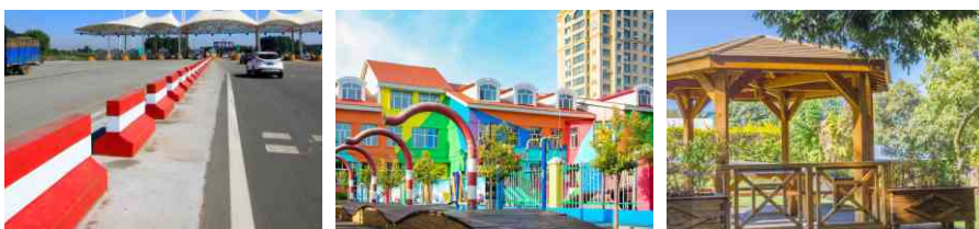
混凝土护栏翻新
